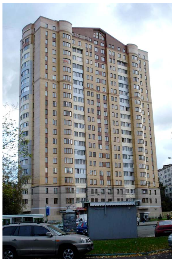
Toà nhà số 9 được xây dựng trên nền đất yếu
